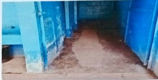
Foto 2: Sustrucción de piso de cemento líquido en sanitarios
