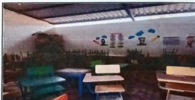
Foto 6: Sustrucción de piso de cemento líquido
