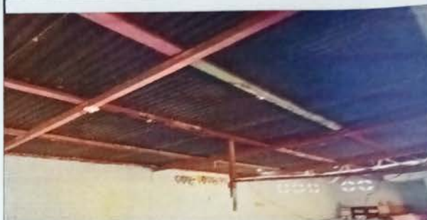
Foto 2: Sustitución de lámina, por lamina troquelada aluzinc calibre 26
