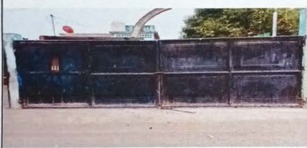
Foto 3: Mantenimiento a portón de metal
