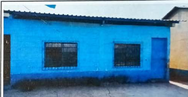
Foto 4: Fabricación e instalación de balcones en ventanas
