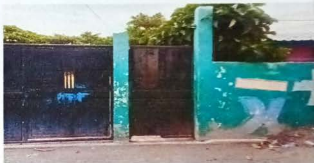
Foto 4: mantenimiento a portón de metal
