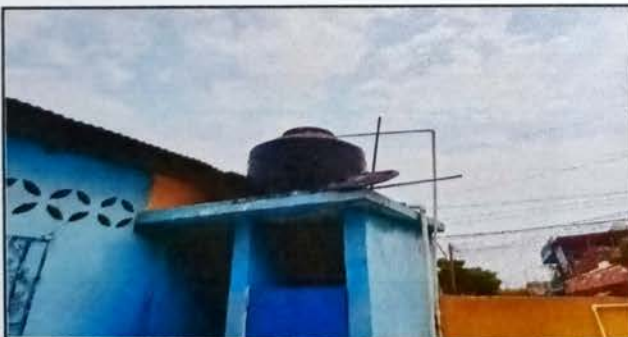
Foto 5: Sustitución de deposito de agua 1,000 lt
