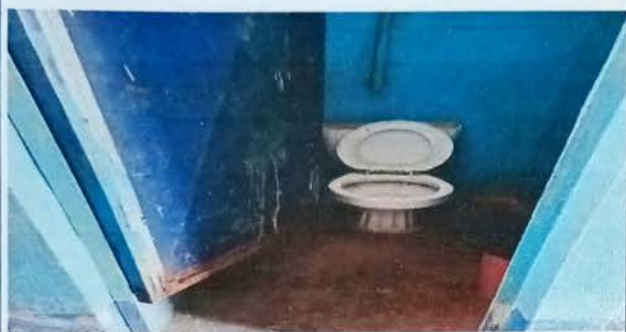
Foto1: Sustrucción de inodoros
