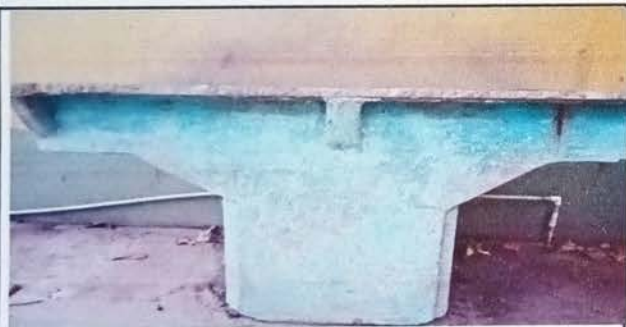
Foto 3: Sustrucción de pila de cemento de dos lavaderos
